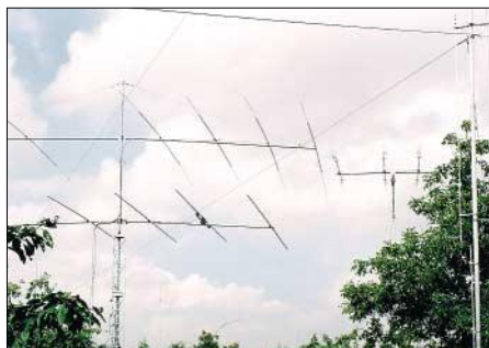
Ein Teil der Antennen – links jeweils 6-Element-Beams für 21 und 28 MHz, hinten rechts der KT-34-Beam, vorn rechts die Voyager für 1,8 bis 14 MHz
