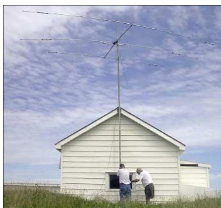
Beim Errichten des 3-Element-Beams
